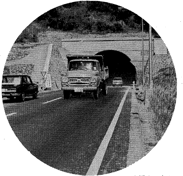
開通した紀見トンネル
